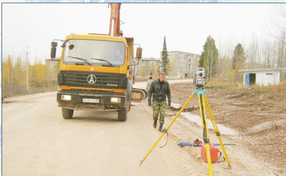
Ремонт автомобильной дороги Хребтовая-Рудногорск-Новоилимск на участке км 86+756 - км 92+756 в Нижнеилимском районе Иркутской области
