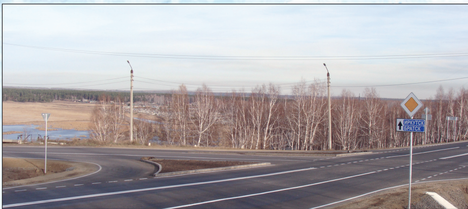
Прием после капитального ремонта участка М-53 в Тулунском районе
